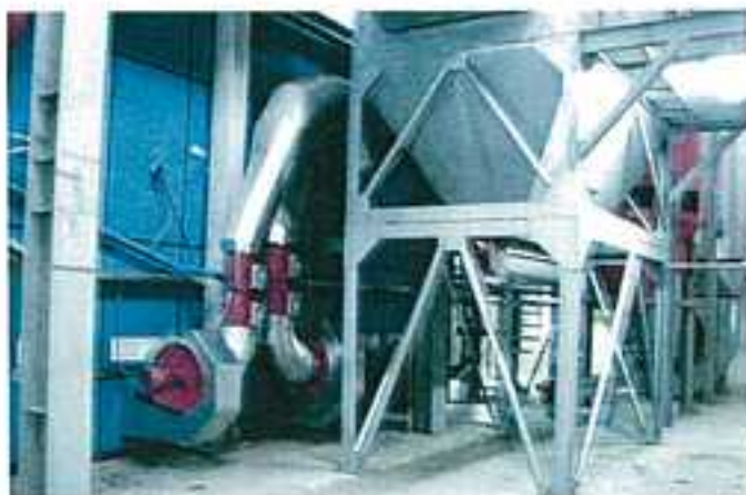
Рис. VII-15 Примоприродные вентиляторы первичного воздуха горения с односторонним всасом
