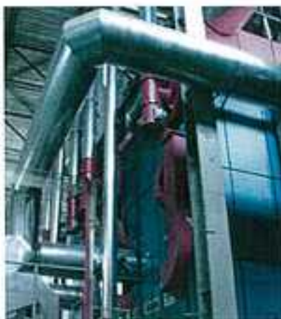
Рис. VII-16 Система вторичного воздуха горения типа SLV
